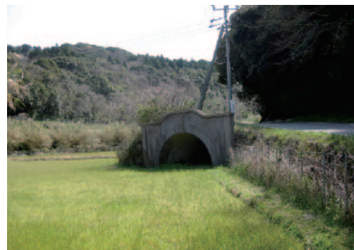
旧杵島炭鉱大鶴鉱業所第2坑口
