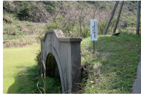
旧杵島炭鉱大鶴鉱業所第2坑口
