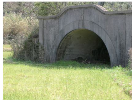
旧杵島炭鉱大鶴鉱業所第2坑口
