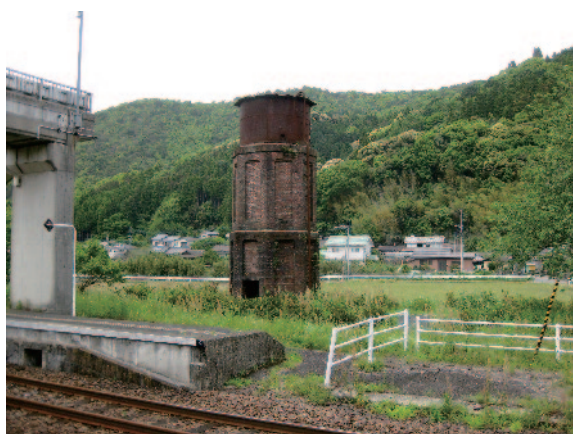
蒸気機関車の給水塔
