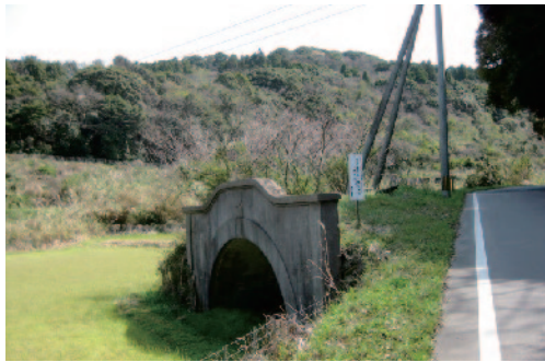
旧杵島炭鉱大鶴鉱業所第2坑口
