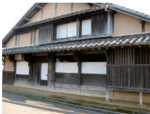
旧長崎街道の土井家住宅
