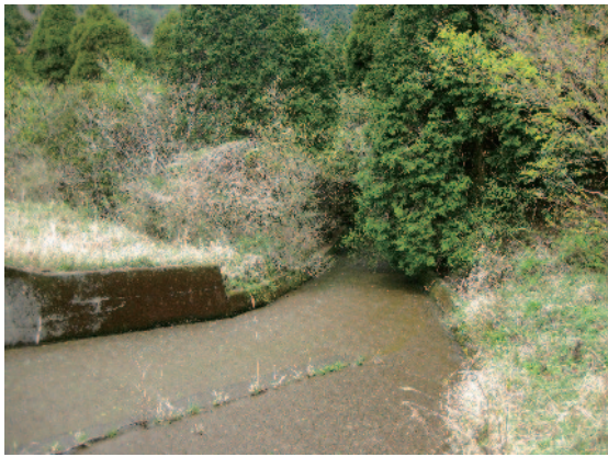
棚田に送水するための管理システム
