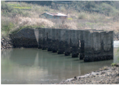
石炭運搬用のための起動用橋脚
