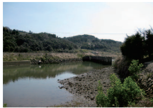
石炭運搬用のための起動用橋脚
